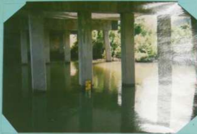
รูปถ่าย แสดงการติดตั้งเสาระดับน้ำคันที่ 1, (0.00 - 2.00 ม.) ซึ่งติดตั้งกับเสาขอมือสะพาน
