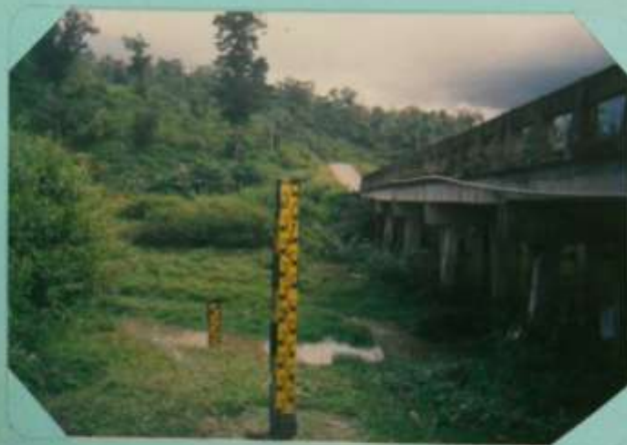
รูปถ่าย ค่ายชลประทาน - ปรับปรุง เขื่อนระดับน้ำที่ ๒, (๒.๐๐ - ๓.๐๐ ม.) และ เขื่อนระดับน้ำที่ ๓, (๓.๐๐ - ๕.๐๐ ม.)
