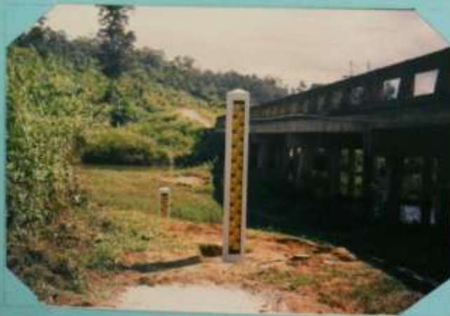
รูปถ่าย แสดงการติดตั้งเสาระดับน้ำใหม่ เป็นเสา คสล. ขนาดมาตรฐานของกองงาน เสาระดับน้ำคันที่ 2, (2.00 - 3.00 ม.) เสาระดับน้ำคันที่ 3, (3.00 - 5.00 ม.)
