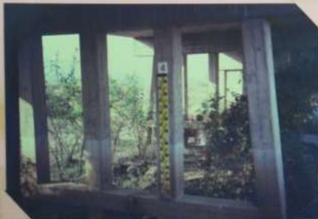
รูปถ่ายอาคารรับน้ำที่ สถานี ๒ (๕๐๐-๗๐๐) ฝั่งเขื่อนทดน้ำ
