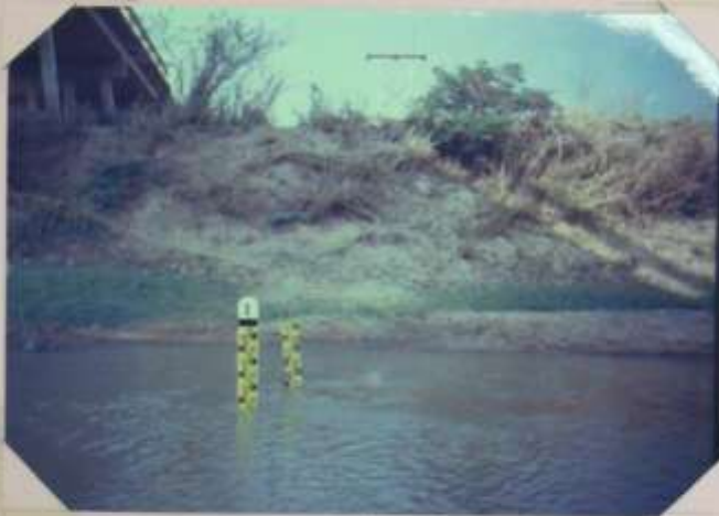
รูปถ่าย สถานีวัดน้ำ สถานี ๒ (๐.๐๐-๑.๐๐ ม.) ฝั่งซ้ายของแม่น้ำ ซึ่งใช้เพื่อวัดระดับน้ำ และค่าการไหลในแม่น้ำ
