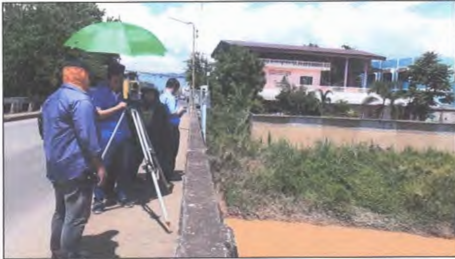
รูปที่ 7 แสดงการสำรวจตำแหน่งพิกัดจุดควบคุม โดยวงรอบด้วยกล้อง Total Station
