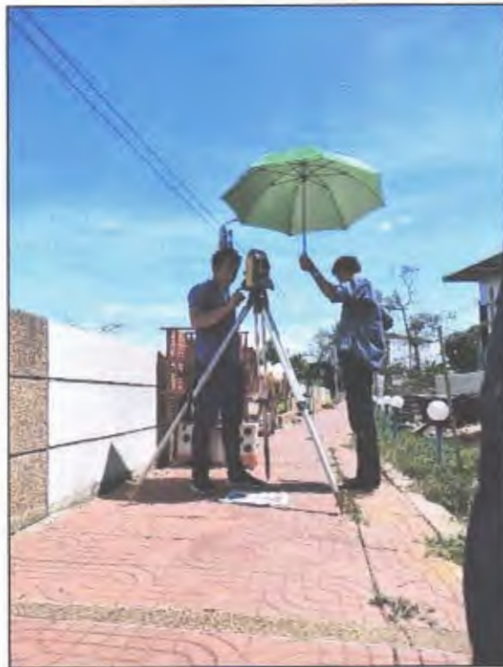
รูปที่ 7 แสดงการสำรวจตำแหน่งพิกัดจุดควบคุม โดยวงรอบด้วยกล้อง Total Station
