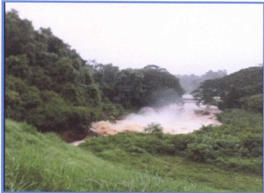
รูปที่ ๓ ความเสียหายบริเวณทำนบดินกับอาคารระบายน้ำล้น ปีพ.ศ. ๒๕๕๙
