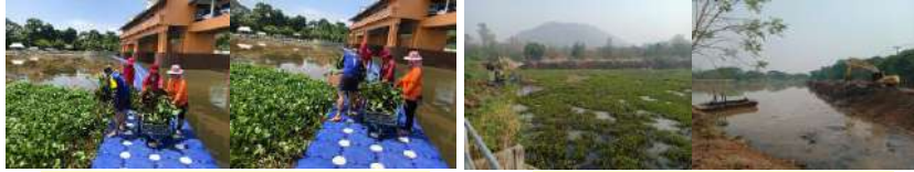
การกำจัดวัชพืช บริเวณหน้าประตูระบายน้ำในลำน้ำปิง (ปตร.ห้วยศาลา)
