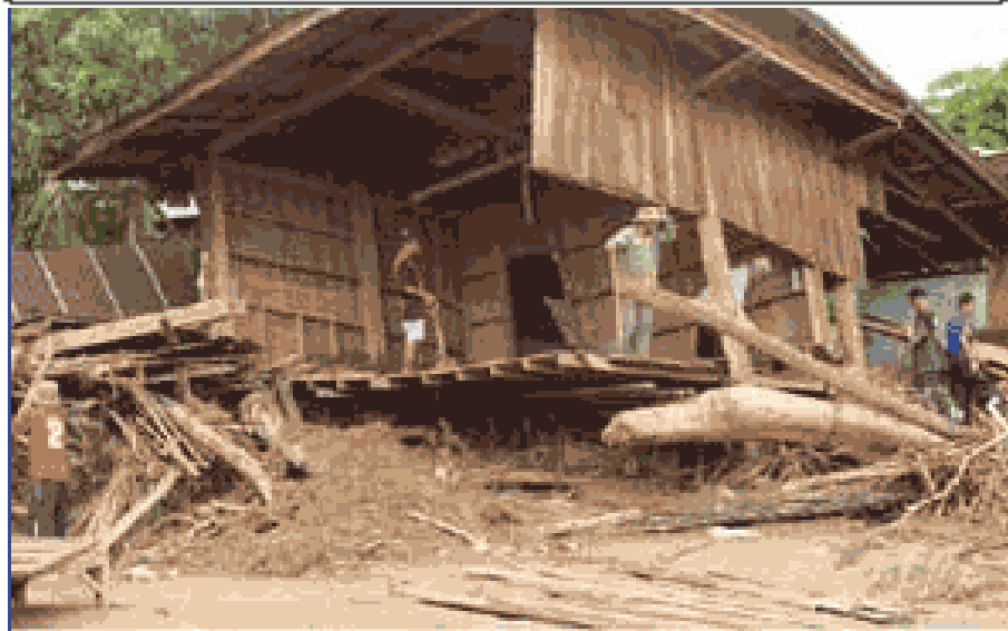
ความเสียหายที่เกิดจากอุทกภัย ที่ อ.แม่ระมาด จ.ตาก พ.ศ.2547
