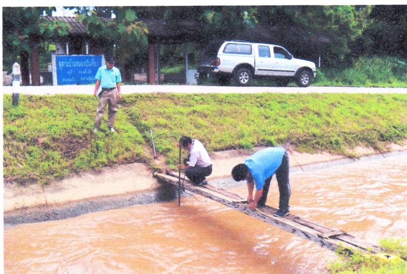
รูปที่ 9. แสดงการตรวจวัดปริมาณการไหลของน้ำตามมาตรฐานกรมชลประทาน
