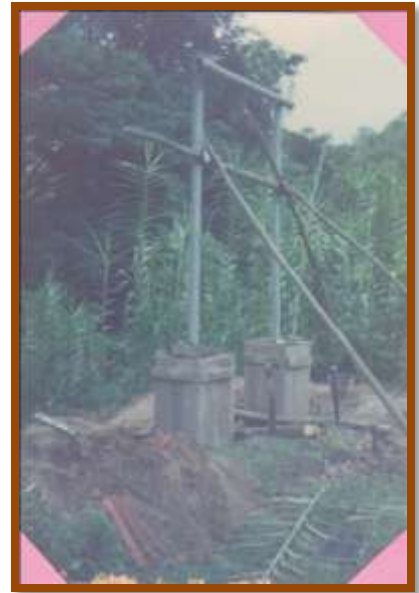
แสดงการประกอบแบบหล่อเสาต่อม่อและติดตั้งโครงสลิงเหล็กแป๊บ
