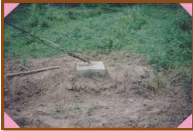
ตอม่อสำหรับยึดลวดสลิงหลังจากสร้างจนสามารถใช้งานได้
