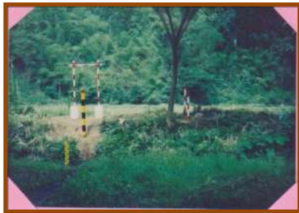
แสดงการติดตั้งโครงสลิง, เสาระดับน้ำและแนวโพนฝังชายของลำน้ำ
