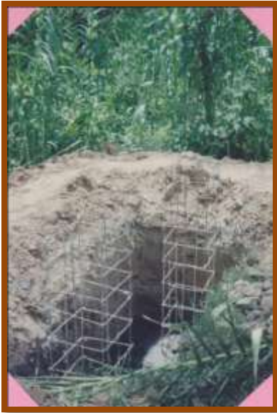
แสดงการผูกเหล็กเสาต่อม่อและฐานรากกับโครงสลิง
