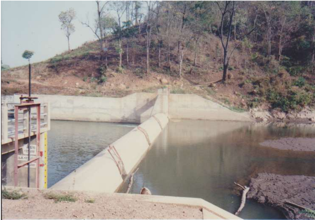
ฝายนอนแนวเหนือน้ำ 500 เมตร
