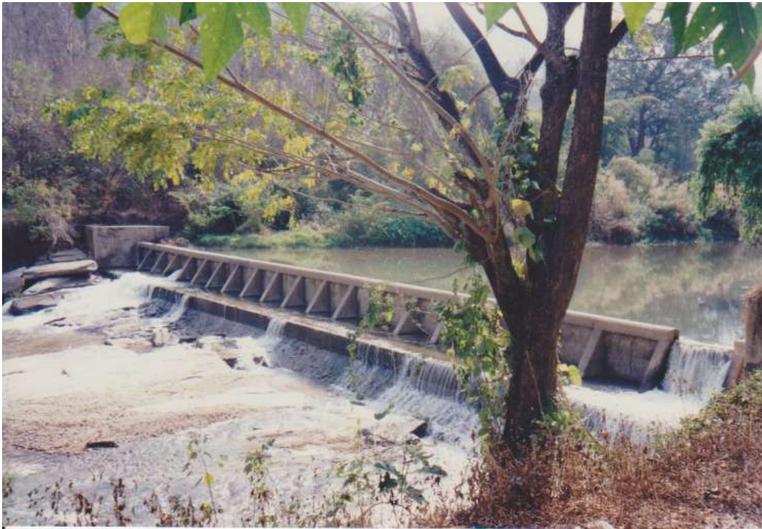
ฝายแม้วางแนวท้ายน้ำ 900 เมตร
