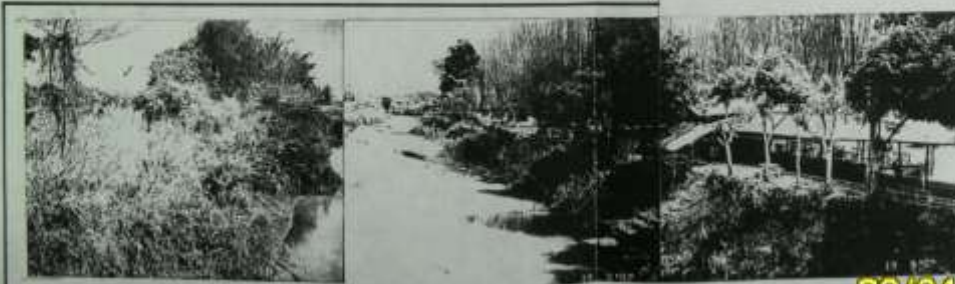
ภาพแสดงท้ายแนวสะพาน
