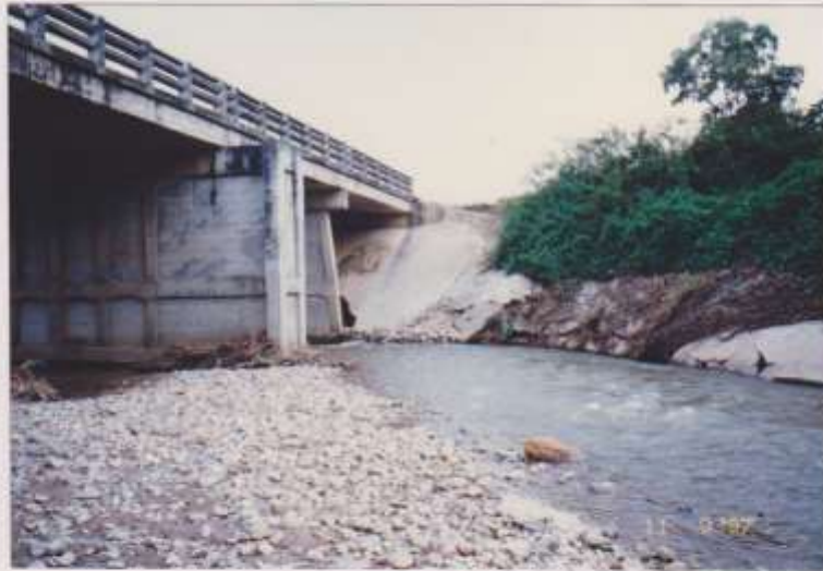
รูปถ่าย แนวสำรวจสะพานด้านเหนือ
