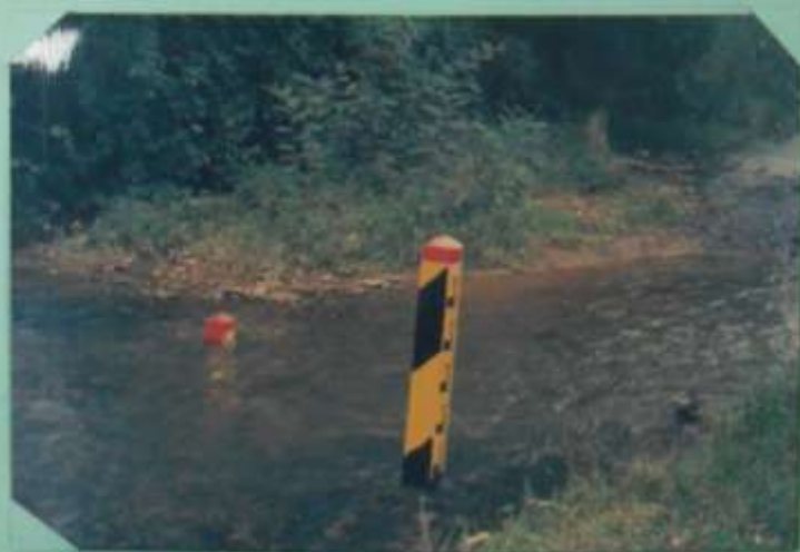
รูปถ่าย หลังซ่อม-ปรับปรุง เสาตรวจระดับน้ำที่ 1, (0.00 - 1.00 ม.) และเสาตรวจระดับน้ำที่ 2, (1.00 - 2.00 ม.)
