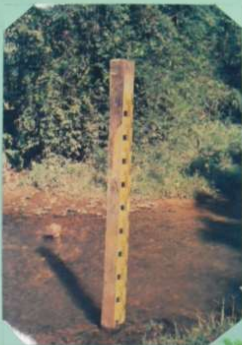
รูปถ่าย ก่อนซ่อม-ปรับปรุง เสาตรวจระดับน้ำที่ 1, (0.00 - 1.00 ม.) และเสาตรวจระดับน้ำที่ 2, (1.00 - 3.00 ม.)
