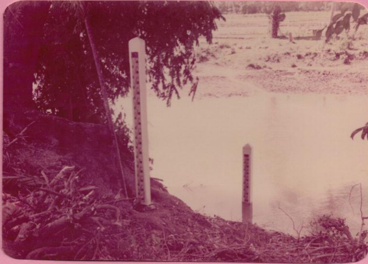
เสาระดับน้ำคอนกรีตสร้างใหม่ Y.22
